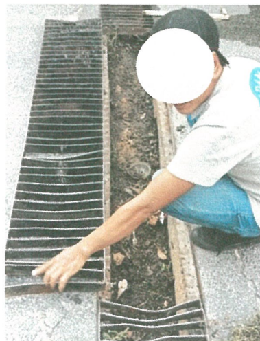
รูปภาพที่ 2.19 ขุดลอกตะกอน
